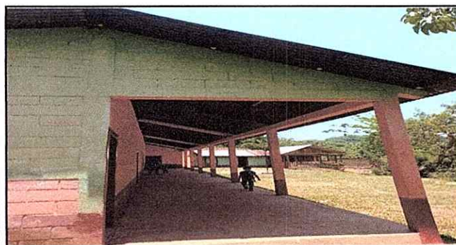
Foto 5: Sustitucion de paredes de madera por Pared de Block
