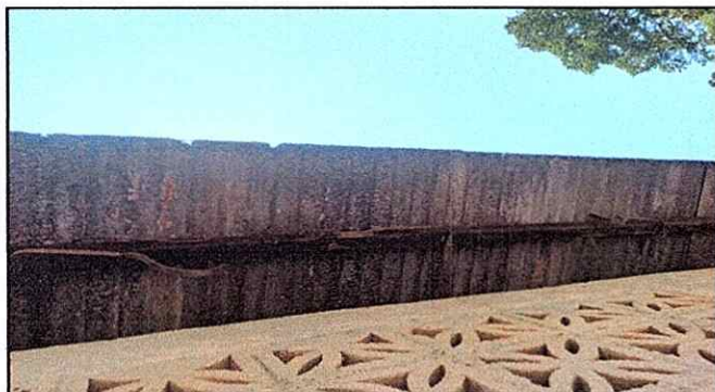
Foto 3: Parte Interna: Instalacion de piso de concreto
