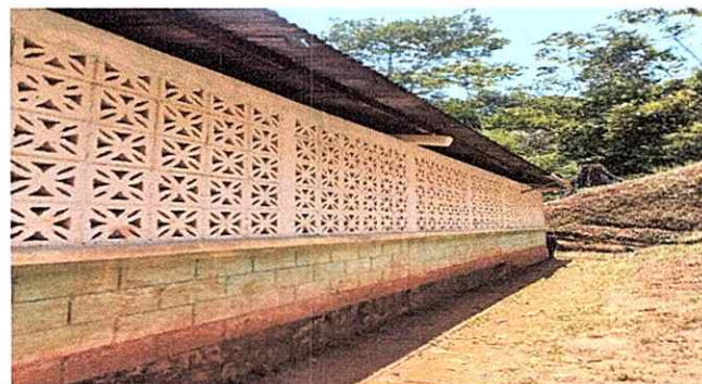
Foto 6: entrada principal: Sustitucion de pared y Puerta
